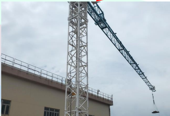
Completion of Tower Crane Erection 天秤安裝完成
